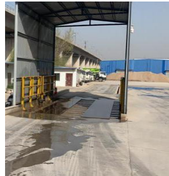
后期需建设的洗车台
