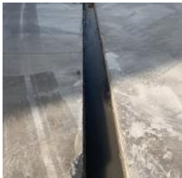
已布设的临时排水沟
